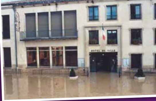
La mairie lors de l'inondation de 2002, source Didier Bondut
