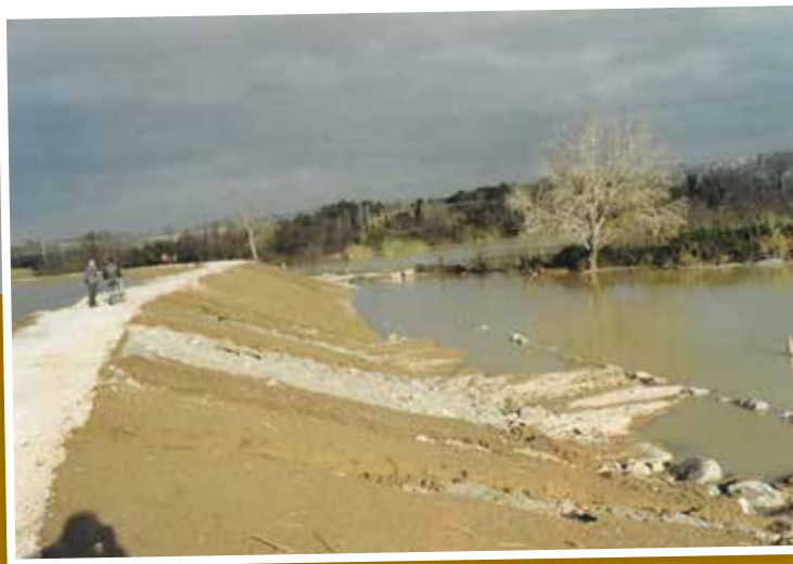
Le déversoir en 2003. A gauche le Rhône, à droite les eaux de surverse. Source Didier Bondut
