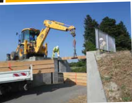
Installation des batardeaux par la mairie. Source mairie d'Aramon
