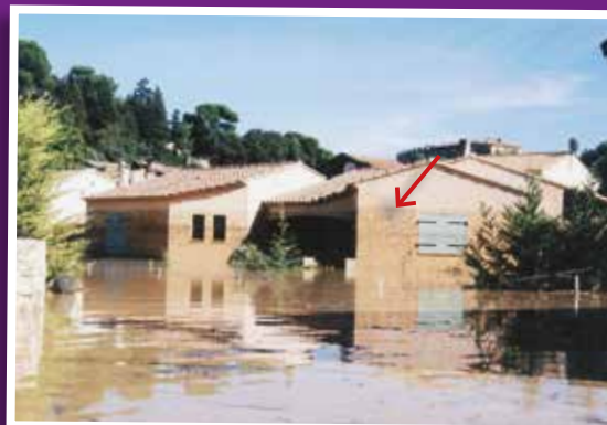
Chemin des Mouttes. Là aussi les laisses* de crues témoignent du niveau de l'eau. - Source Christian Gellet
