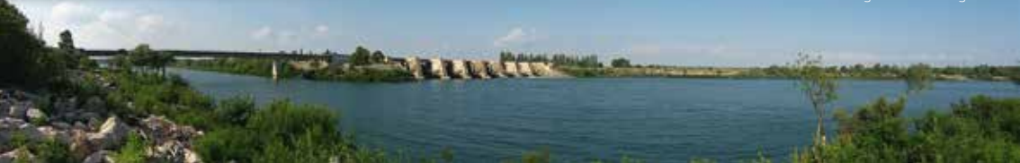
la confluence du Rhône et du Gardon au barrage de Vallabrègues
