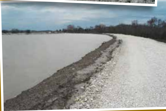
14 décembre 2003. Le Rhône contre la nouvelle digue confortée. Source Didier Bondut
