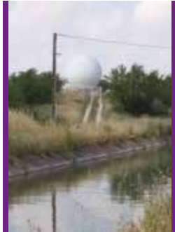
Radar de MétéoFrance à Manduel près de Nîmes.
