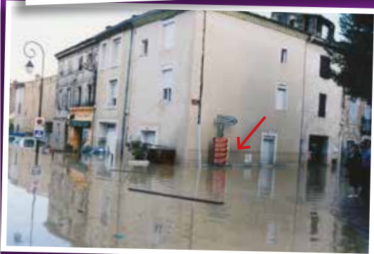
L'endroit où vous vous trouvez correspond à la limite de l'emprise de cette inondation. Remarquez le niveau de l'eau visible par les laisses* de crue sur la maison située en face de vous. Source Christian Gellet
