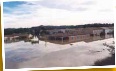
Le quartier des Charmettes inondé après la rupture de la digue en 2002. Source : Didier Bondut.
